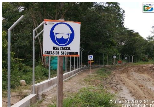
Fotografía – Señalización de uso de EPP en obra Fuente: Consorcio DS
